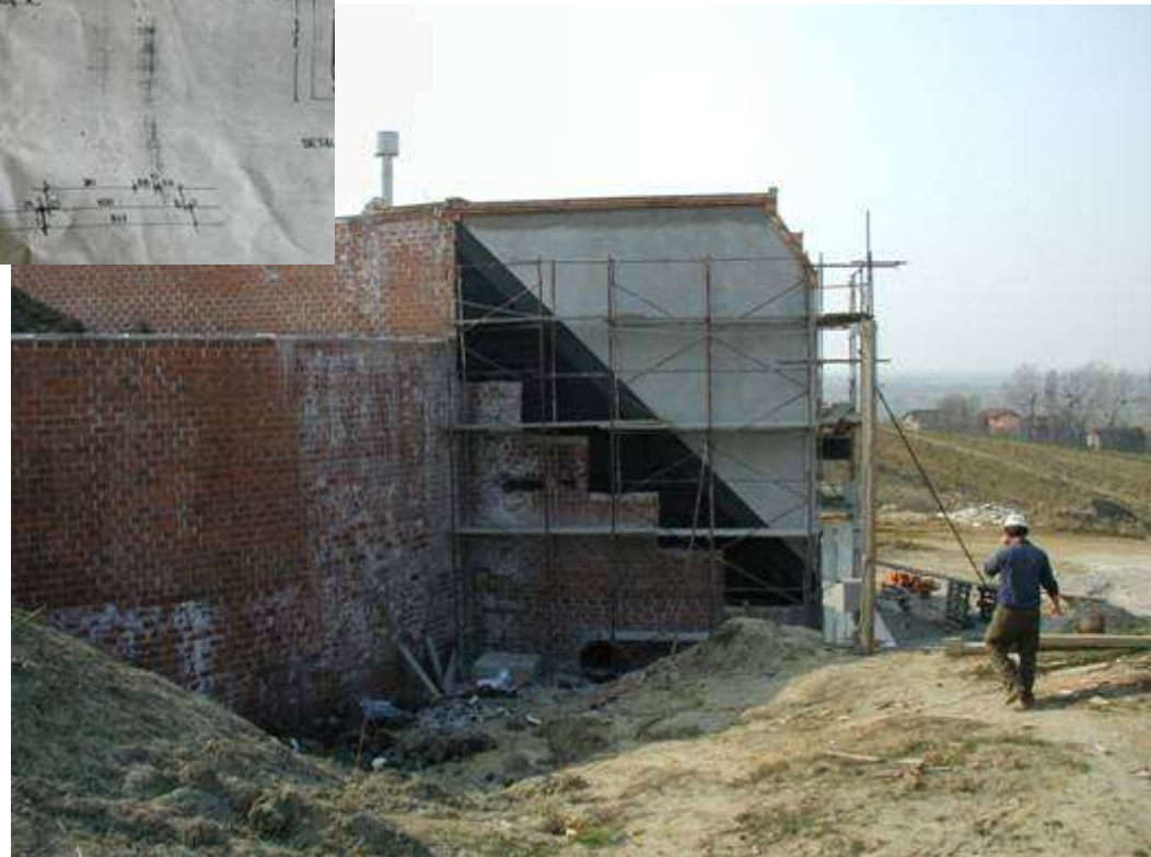
Vodosprema u blizini Varaždina
