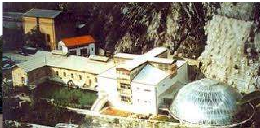
Izvor i crpna stanica Zvir
