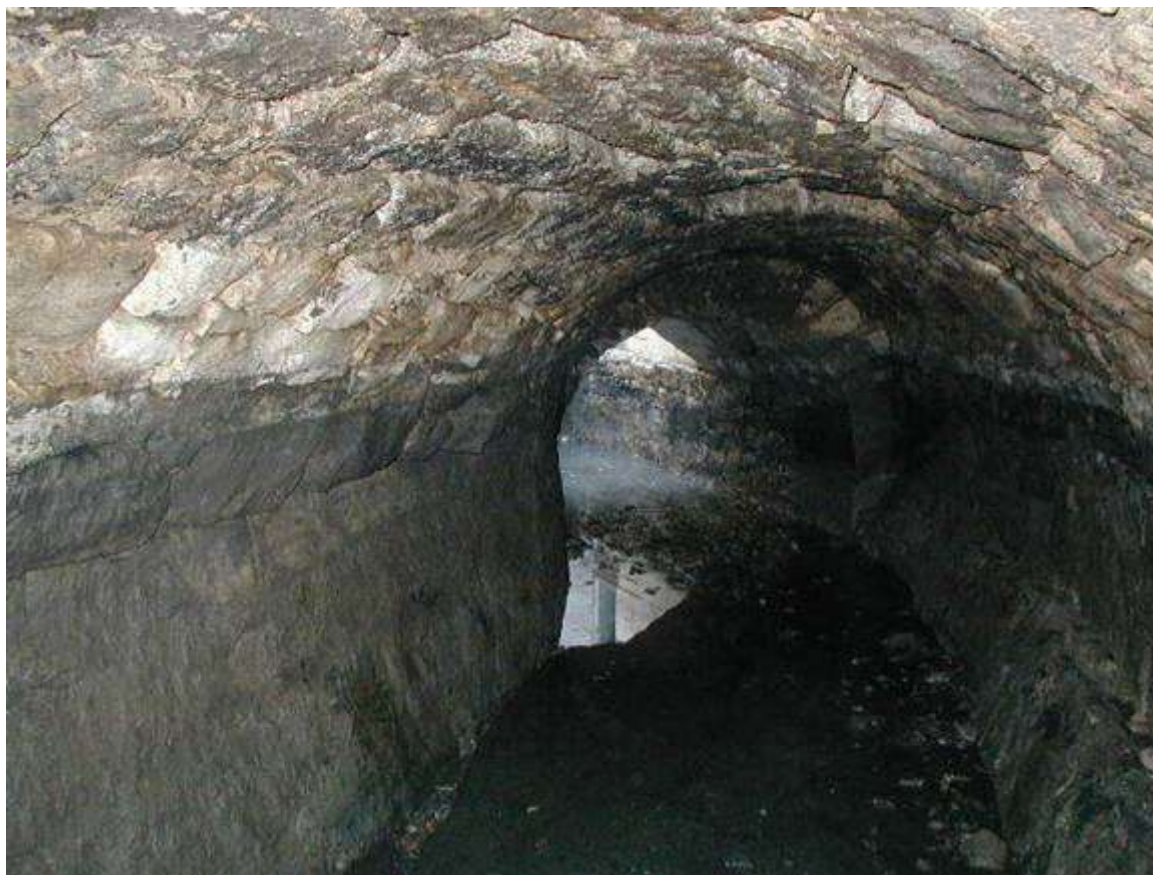
Kanal izveden u kamenu (Pula)
