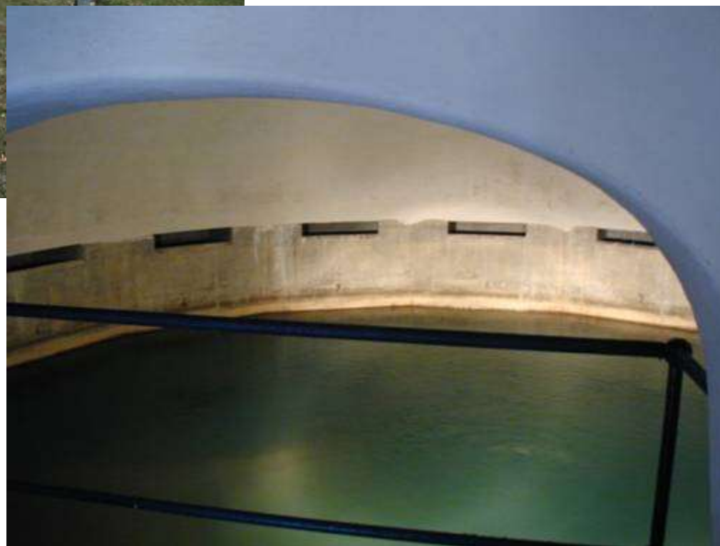
Kaptaža izvora Sv. Ivan (Buzet) voda izvire iz krških kaverni
